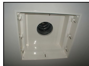
Vue d'un caisson 6x6 depuis le dessous, sans filtre et grille
