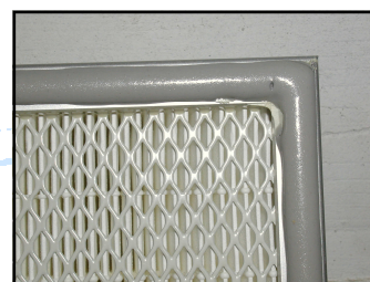
Vue d'un filtre avec cadre à joint EPDM
