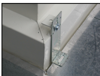
Vue d'une patte d'accrochage. Fixation au moyen d'une équerre sur le plafond
